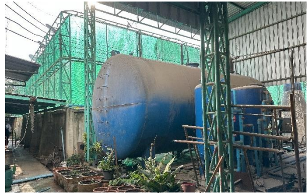
ถังแคปซูล (ถังเก็บน้ำจากแม่น้ำป่าสัก) และถังกรอง (ใช้กรองน้ำบาดาลจากถังแชมเปญ)
