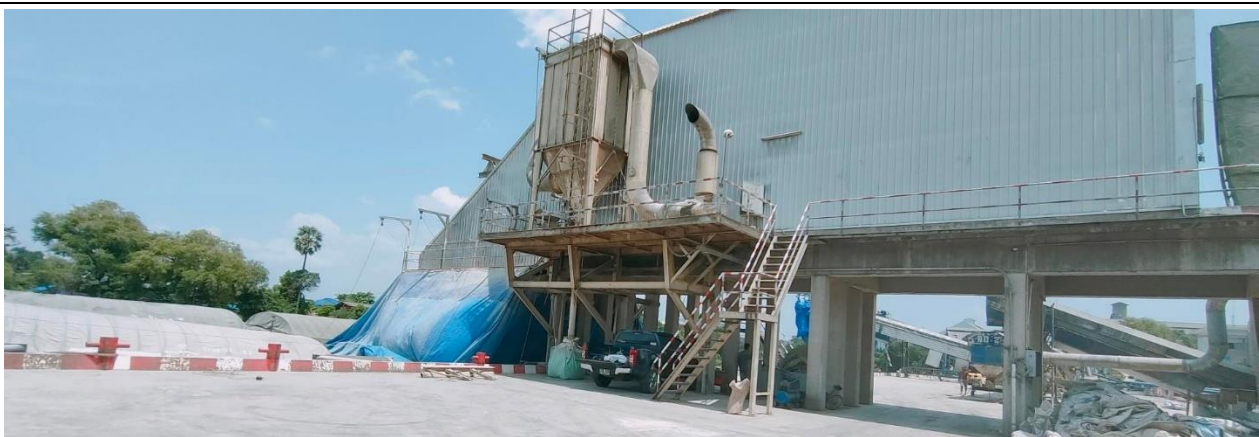
ท่าเทียบเรือที่ 1 โกรกลิ้งสินค้า A และเครื่องดักฝุ่นแบบถุงกรอง (Bag Filter)
