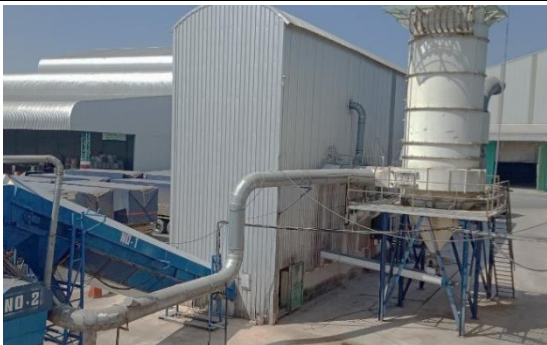
โกรกลิ้งสินค้า B และเครื่องดักฝุ่นแบบถุงกรอง (Bag Filter)
